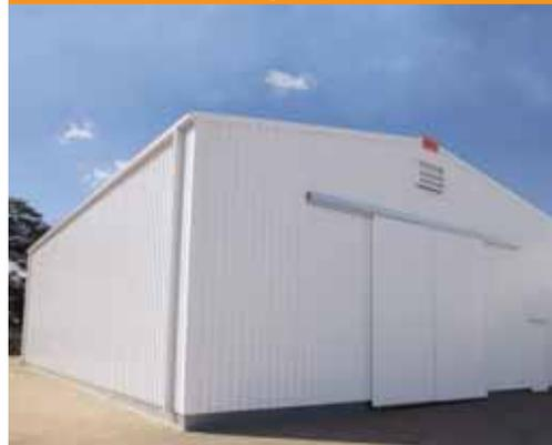
Com tecnologia inovadora única, a FRISOMAT, fabricante belga de galpões metálicos pré-fabricados, desenvolve e produz *kits* para galpões que podem ser facilmente transportados e montados no local, em absoluta conformidade com as normas brasileiras.
